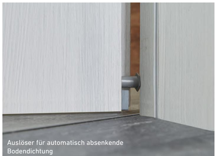
Auslöser für automatisch absenkende Bodendichtung
