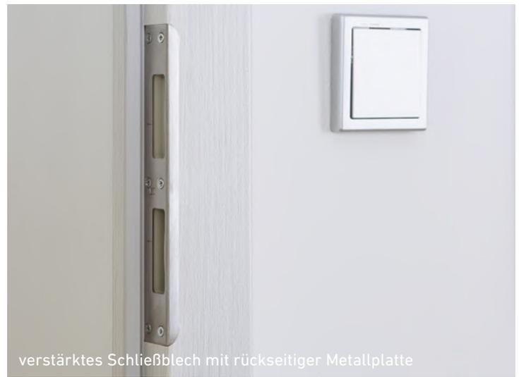
verstärktes Schließblech mit rückseitiger Metallplatte
