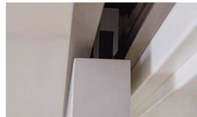
Befestigung einer Holztür im Schiebetürbeschlag Line
